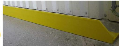
Der Boden jeder Lieferstelle, lokalisiert entlang der Fertigungslinie, vorgesehen für Behältertransport (Gabelstapler), ist vor mechanischen Beschädigungen durch das Anbringen eines Schutzbleches direkt auf den Boden zu schützen.
